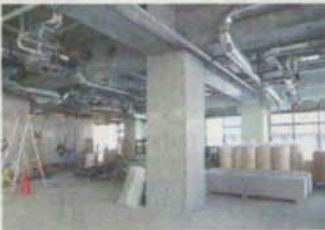
スケジュールの遅れなく竣工を迎える
